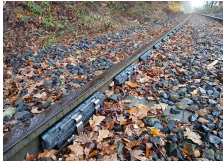
Schienenstegdämpfer reduzieren den Schienenlärm um bis zu 3 - 6 dB
