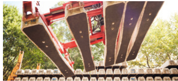
Einbau Schwellenschienen Berlin-Cottbus - Foto © Gezeiner Werkstoffe GmbH
